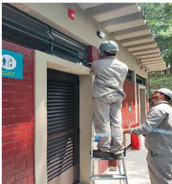
Figura 237 - REFORÇO DE MASSA NOS VIDROS (DURANTE)
