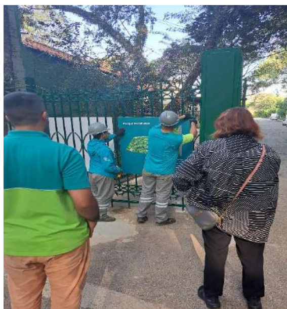
Figura 214 - IMPLANTAÇÃO DE PLACA NOVA (DURANTE)
