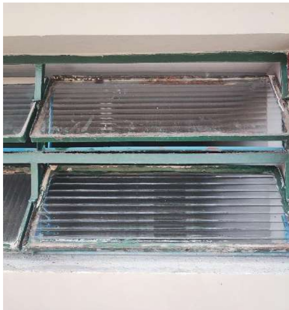
Figura 237 - REFORÇO DE MASSA NOS VIDROS (DURANTE)
