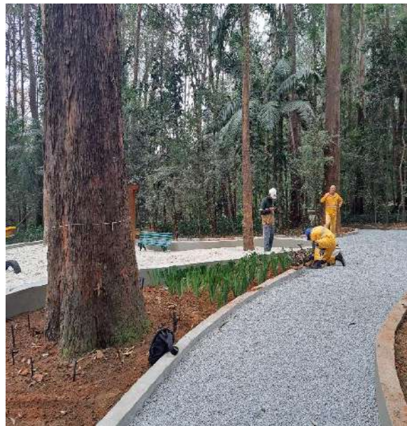
Figura 28 - PLANTIO NOS CANTEIROS ADJACENTES AO PLAYGROUND (DURANTE)
