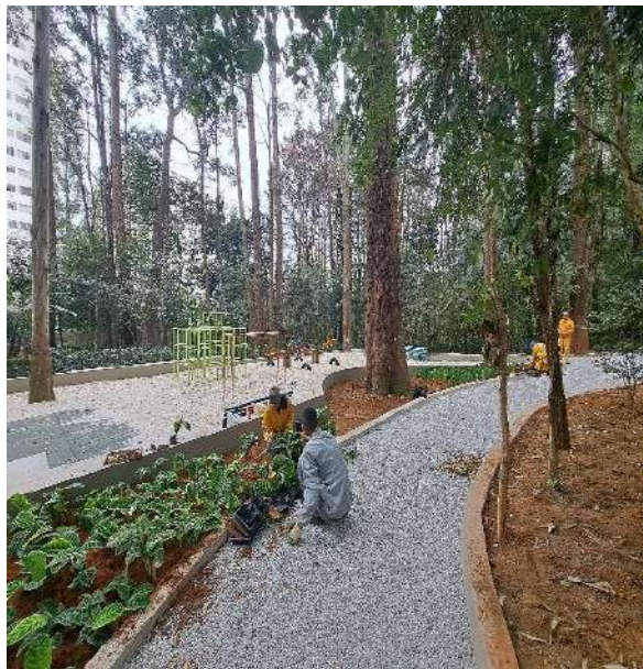
Figura 27 - PLANTIO NOS CANTEIROS ADJACENTES AO PLAYGROUND (DURANTE)
