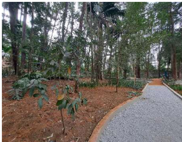
Figura 23 - PLANTIO NOS CANTEIROS ADJACENTES AO PLAYGROUND (DURANTE)
