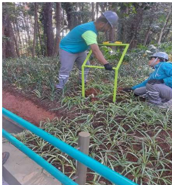
Figura 212 - IMPLANTAÇÃO DE SUPORTE E PLACA NOVA (DURANTE)
