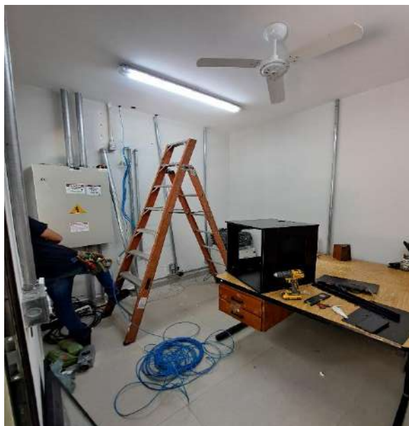
Figura 155 - INSTALAÇÃO DO RACK DE ARMAZENAMENTO DE SISTEMA
