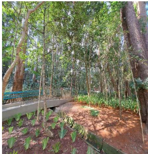
Figura 92 - PLANTIO NOS CANTEIROS ADJACENTES À RAMPA ACESSÍVEL (DURANTE)
