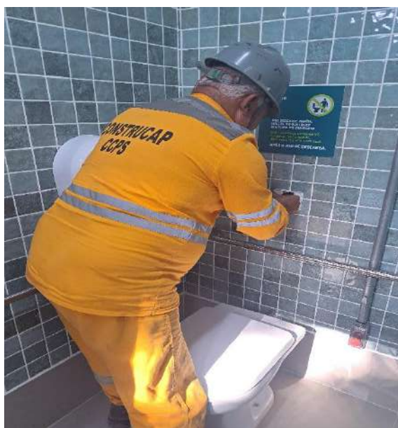
Figura 225 - AJUSTE NA VÁLVULA DA DESCARGA
