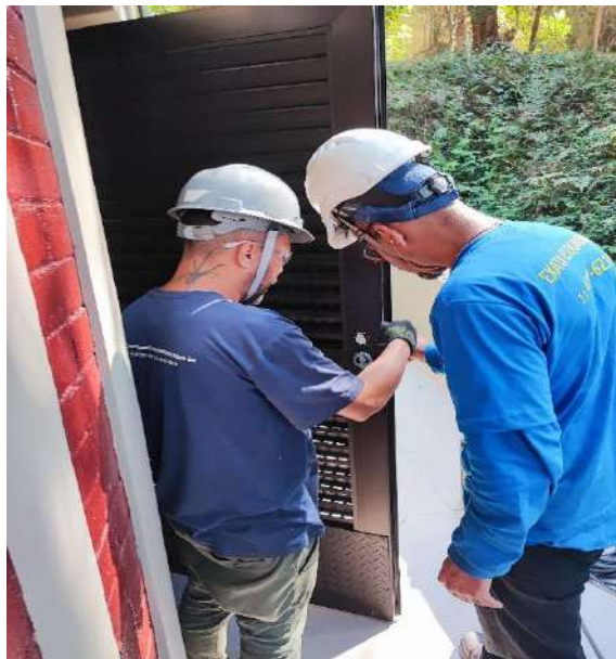
Figura 223 - REPARO DA MAÇANETA DA PORTA (DURANTE)
