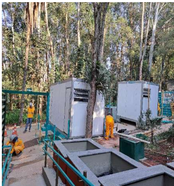
Figura 201 - RETIRADA DE CONTÊINERES (ANTES)
