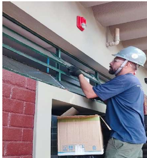
Figura 238 - REFORÇO DE MASSA NOS VIDROS (DEPOIS)
