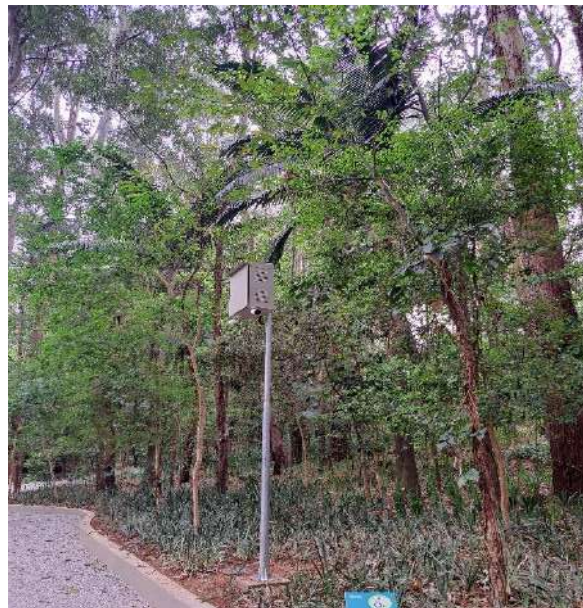
Figura 152 - INSTALAÇÃO DAS CÂMERAS DE SEGURANÇA
