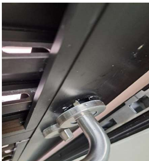
Figura 222 - REPARO DA MAÇANETA DA PORTA (ANTES)
