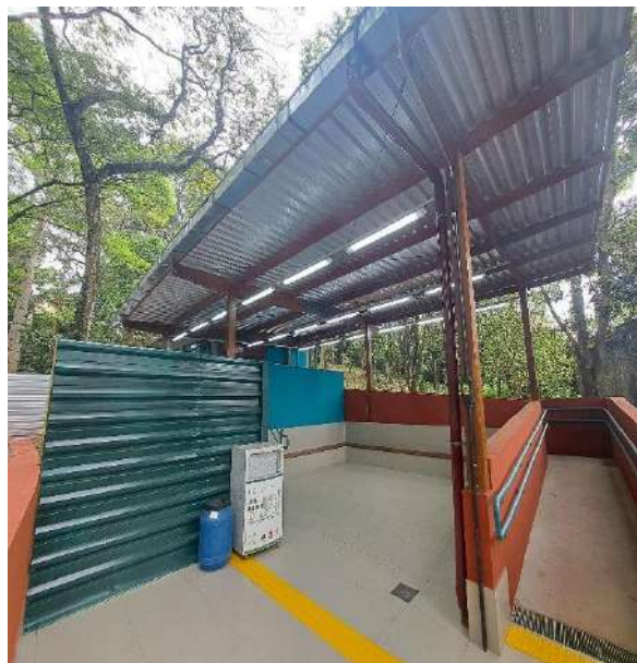
Figura 182 - LIMPEZA DA ÁREA DE CONVIVÊNCIA
