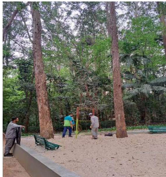
Figura 216 - IMPLANTAÇÃO DE SUPORTE E PLACA NOVA (DURANTE)
