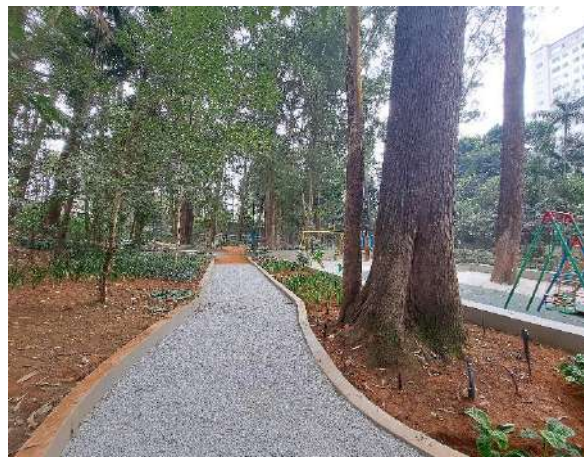
Figura 24 - PLANTIO NOS CANTEIROS ADJACENTES AO PLAYGROUND (DURANTE)
