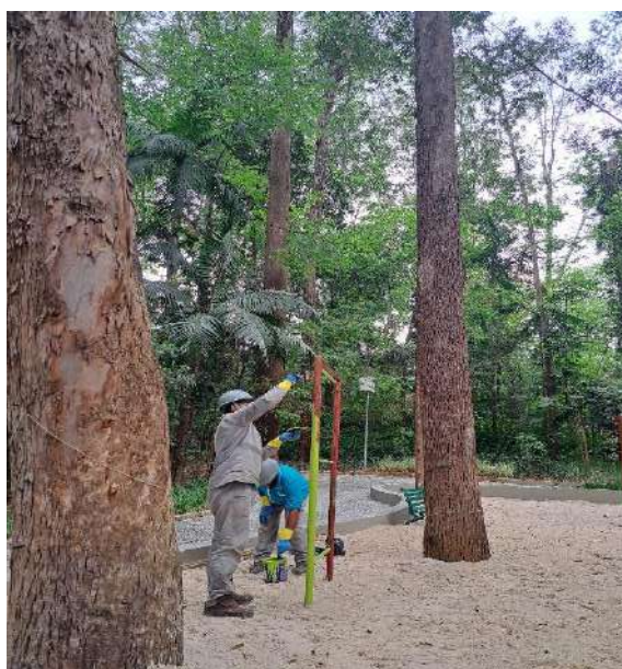
Figura 217 - IMPLANTAÇÃO DE SUPORTE E PLACA NOVA (DURANTE)
