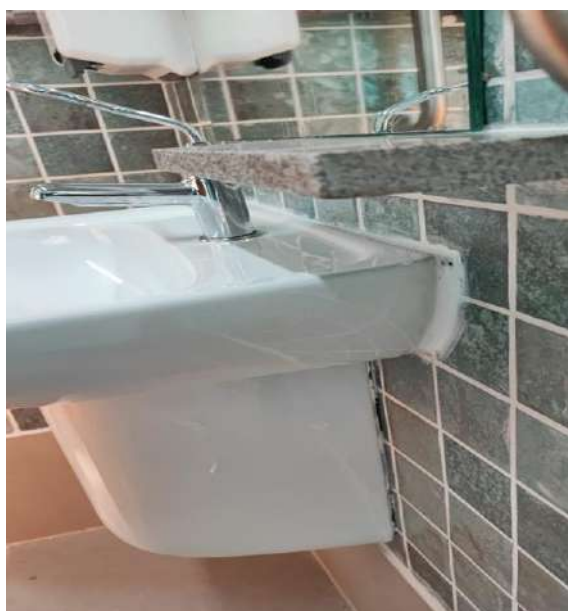
Figura 229 - REPARO NO LAVATÓRIO DO BANHEIRO (DEPOIS)
