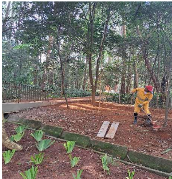
Figura 91 - PLANTIO NOS CANTEIROS ADJACENTES À RAMPA ACESSÍVEL (ANTES)
