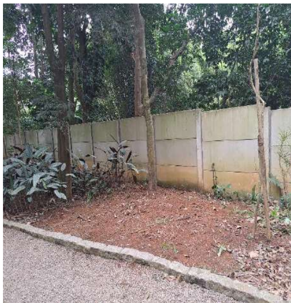
Figura 87 - PLANTIO PARA PREENCHIMENTO DE CANTEIRO (ANTES)
