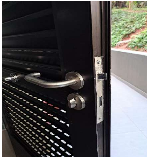
Figura 224 - REPARO DA MAÇANETA DA PORTA (DEPOIS)
