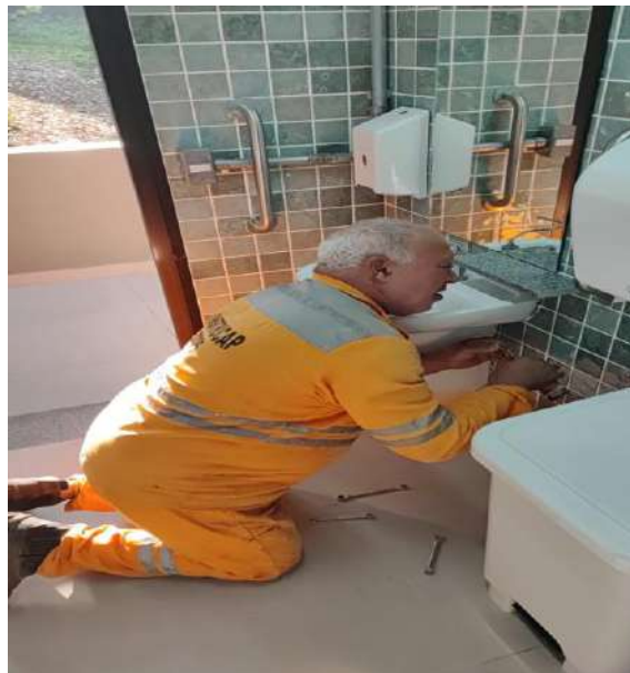
Figura 228 - REPARO NO LAVATÓRIO DO BANHEIRO (DURANTE)
