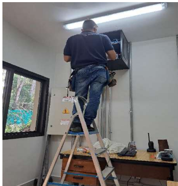
Figura 156 - INSTALAÇÃO DO RACK DE ARMAZENAMENTO DE SISTEMA
