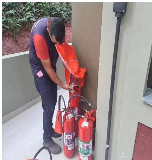
Figura 162 - RECARGA DOS EXTINTORES REALIZADA PELA EMPRESA OSASFIRE
