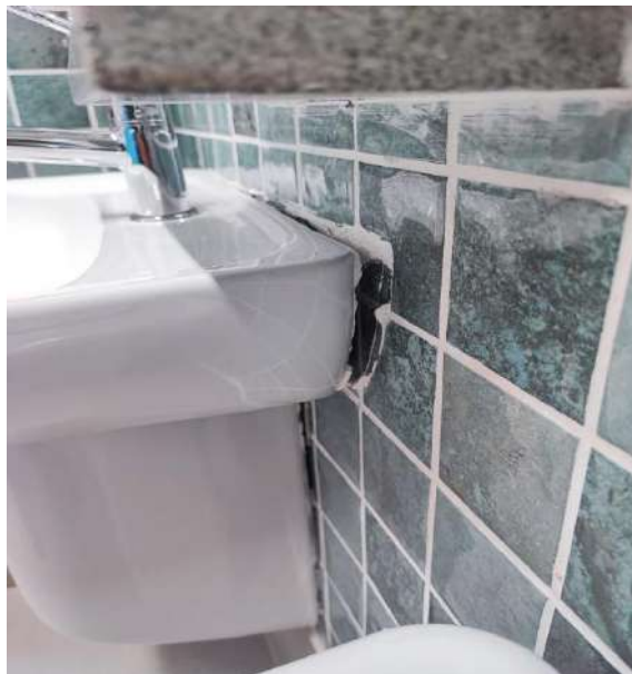
Figura 227 - REPARO NO LAVATÓRIO DO BANHEIRO (ANTES)
