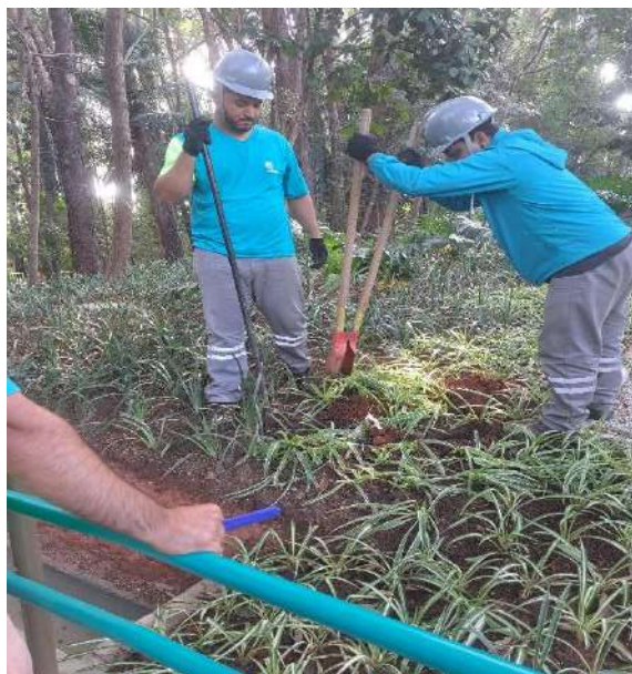
Figura 211 - IMPLANTAÇÃO DE SUPORTE E PLACA NOVA (DURANTE)
