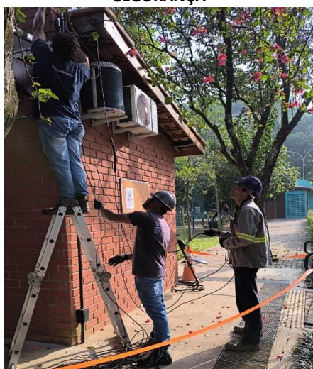
FIGURA 37 - INSTALAÇÃO DAS CÂMERAS DE SEGURANÇA
