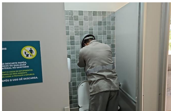
Figura 127 MANUTENÇÃO DE DESCARGA NOS SANITÁRIOS
