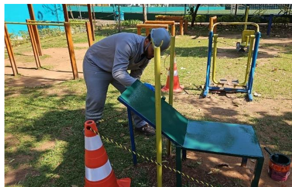
Figura 119 REFORMA DA ACADEMIA - PINTURA
