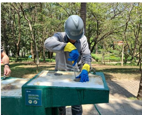
Figura 114 BEBEDOURO DESENTUPIDO
