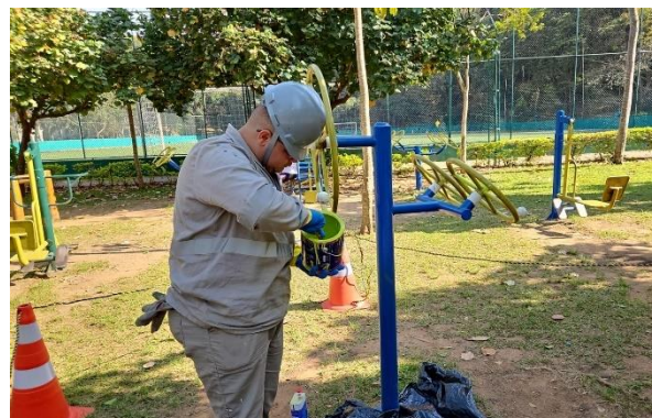
Figura 117 REFORMA DA ACADEMIA - PINTURA
