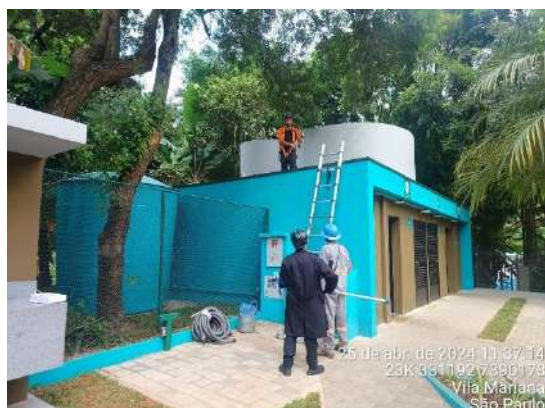
Figura 395: Higienização dos reservatórios de água potável - Banheiro 4 - Orangebio
