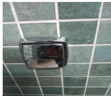
Figura 534 Troca da válvula hidra - Depois
