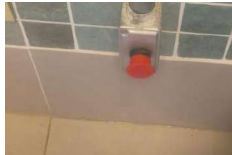
Figura 542 Troca de botão de alarme - Depois
