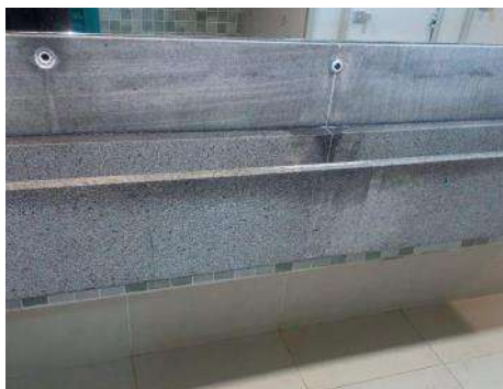
Figura 535 Instalação de torneiras - Antes
