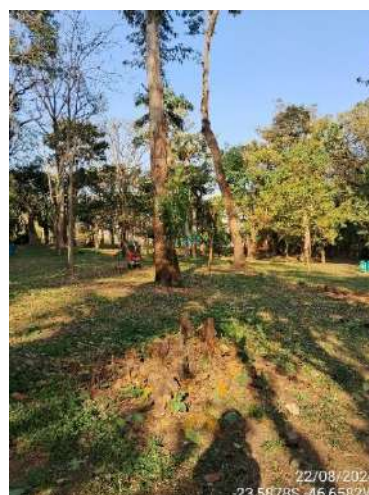
Figura 233 - Remoção de figueira-mata-pau
