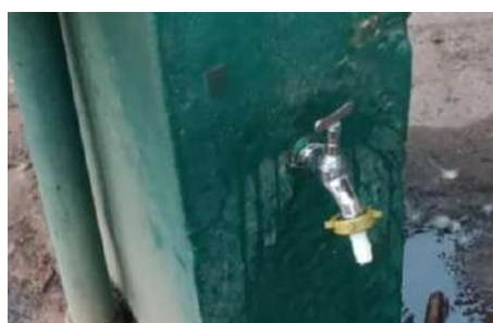
Figura 538 Troca de torneiras - Depois
