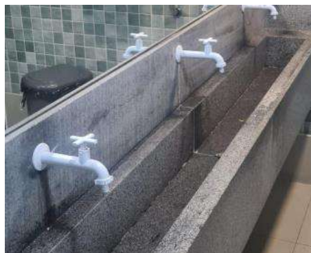
Figura 537 Instalação de torneiras - Depois
