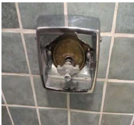
Figura 533 Troca da válvula hidra - Antes
