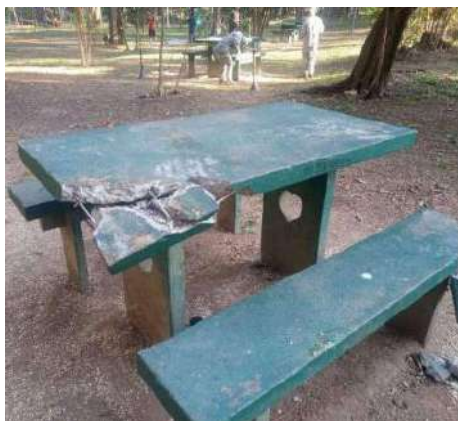
Figura 523 Manutenção Mesa - Antes.
