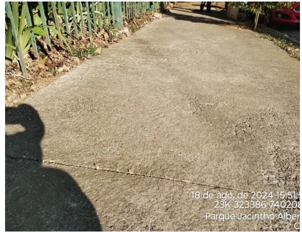
Figura 76. Após a limpeza de calçadas (área externa)
