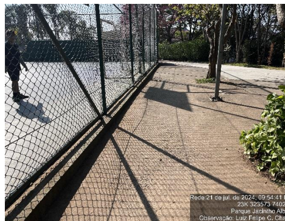
Figura 62. Após a limpeza próximo das quadras
