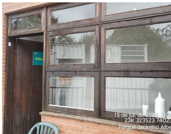
Figura 90. Após a limpeza de janelas
