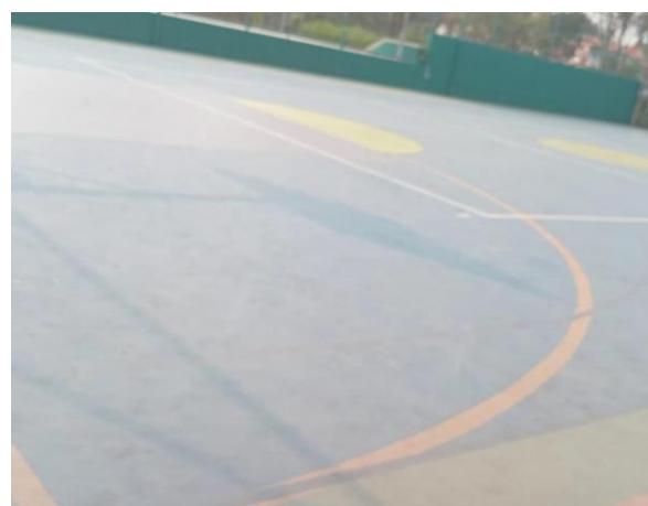
Figura 54. Após a limpeza da quadra poliesportiva
