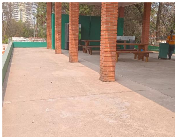
Figura 48. Após a limpeza do espaço multiuso
