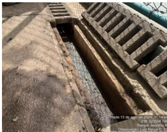
Figura 92. Após a limpeza de canaletas
