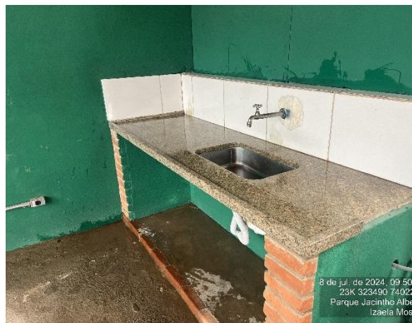
Figura 46. Após a limpeza da pia do Espaço Multiuso
