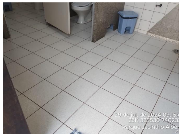
Figura 44. Após a limpeza de banheiros
