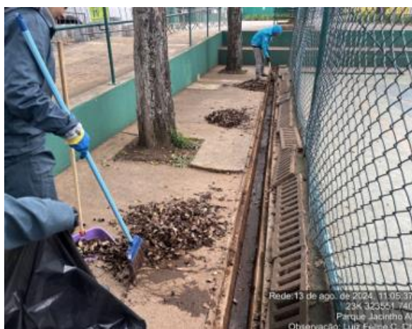
Figura 91. Durante a limpeza de canaletas
