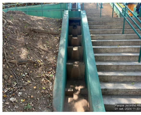
Figura 68. Após a limpeza de canaletas
