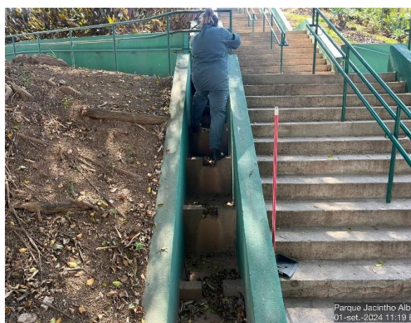
Figura 67. Durante a limpeza de canaletas
