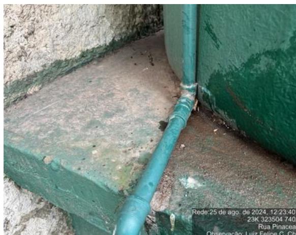
Figura 148. Após do conserto de cano de caixa d'água
