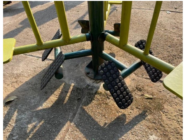
Figura 110 - SUBSTITUIÇÃO DE PEDAIS DE APARELHO DE ACADEMIA
