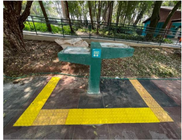
Figura 100 - INSTALAÇÃO DE PISO TÁTIL (DEPOIS)
