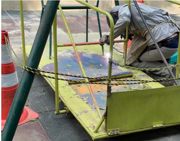
Figura 103 - MANUTENÇÃO DE BALANÇO PCD
