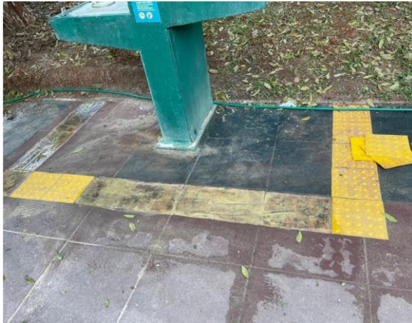
Figura 99 - INSTALAÇÃO DE PISO TÁTIL (ANTES)
