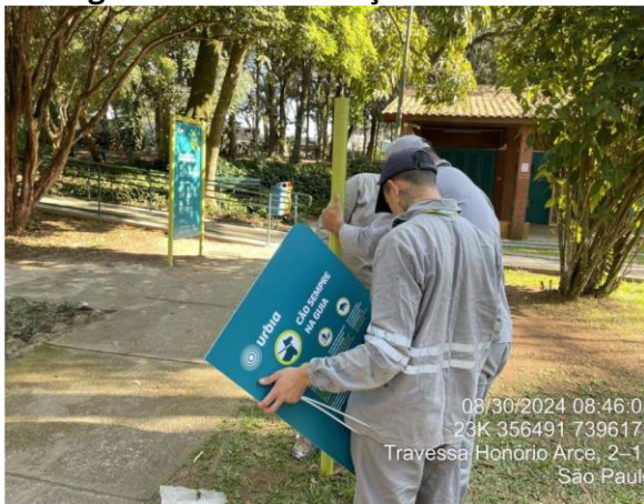
Figura 101 - INSTALAÇÃO DE PLACA
