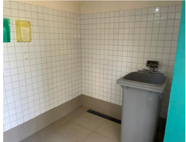
Figura 84 - LIMPEZA DE DEPÓSITO DE RESÍDUOS (DEPOIS)
