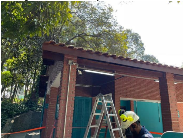
Figura 71 - INSTALAÇÃO DE CÂMERAS
