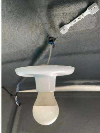
Figura 97 - SUBSTITUIÇÃO DE LÂMPADA DA GUARITA
