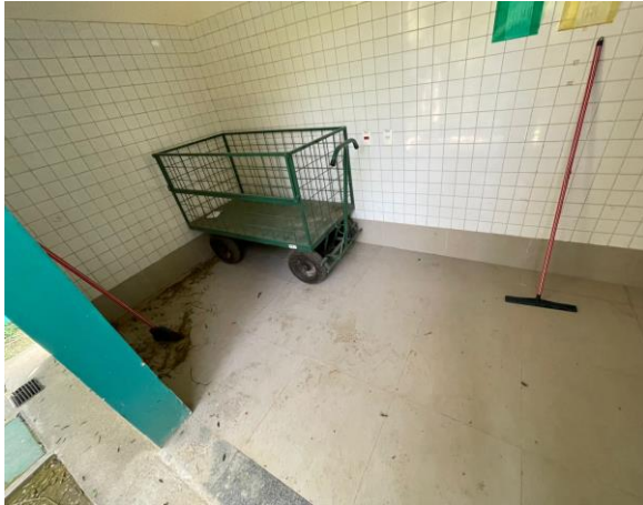
Figura 81 - LIMPEZA DE DEPÓSITO DE RESÍDUOS (ANTES)
