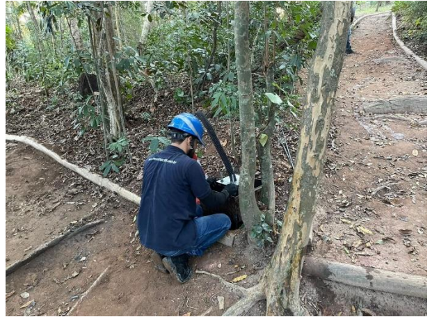
Figura 64 - INSTALAÇÃO DE CÂMERAS
