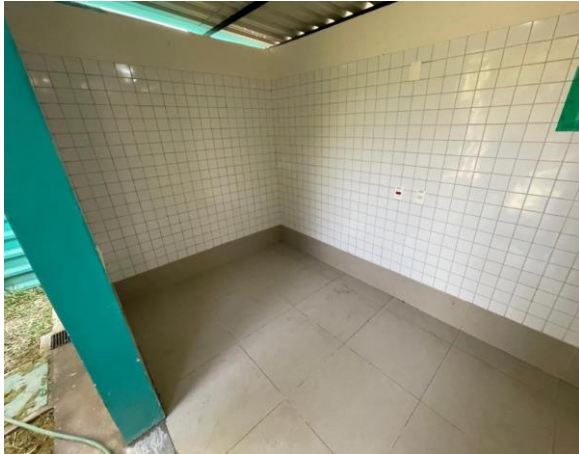
Figura 83 - LIMPEZA DE DEPÓSITO DE RESÍDUOS (DEPOIS)
