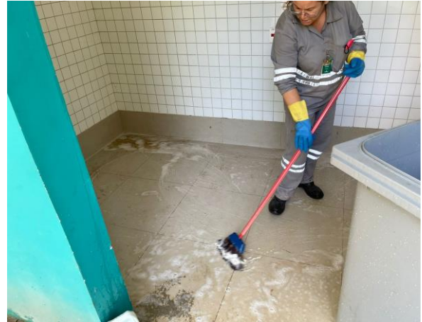
Figura 82 - LIMPEZA DE DEPÓSITO DE RESÍDUOS (DURANTE)
