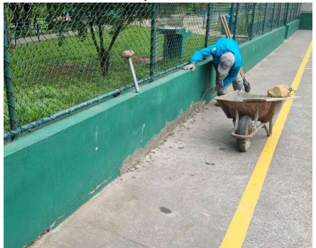
Figura 143 conserto de parede quebrada na quadra
