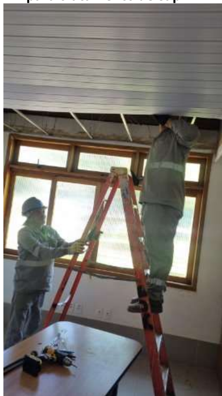
Figura 152 retirada do forro da administração para tratamento de cupim
