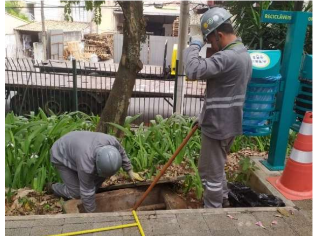
Figura 135 manutenção da caixa de esgoto
