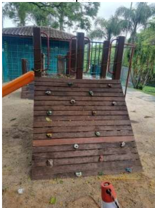
Figura 151 manutenção em brinquedo - depois
