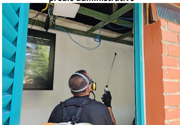
Figura 43 descupinização do telhado do prédio administrativo
