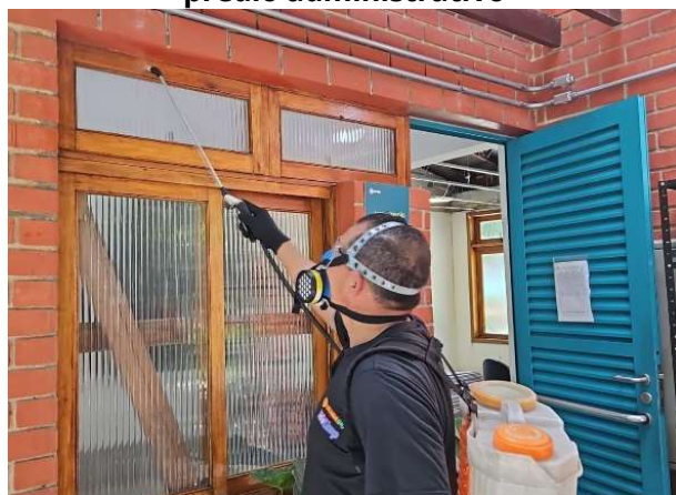
Figura 43 descupinização do telhado do prédio administrativo
