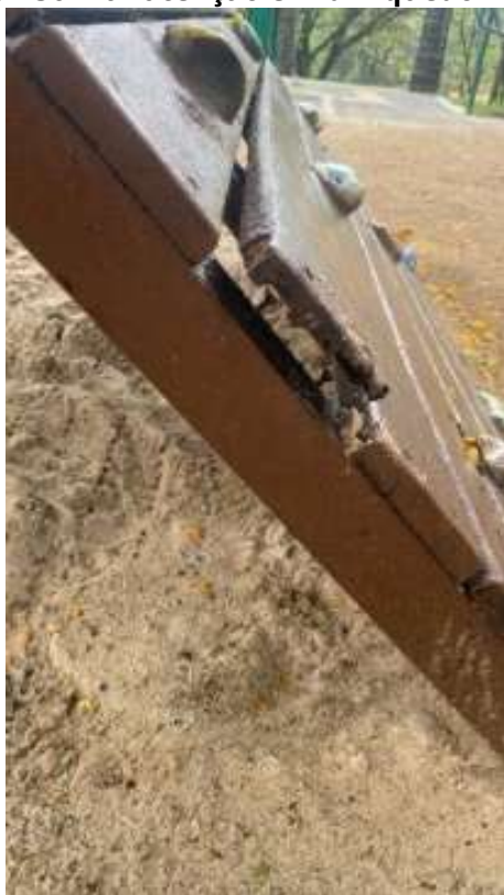
Figura 152 retirada do forro da administração para tratamento de cupim
