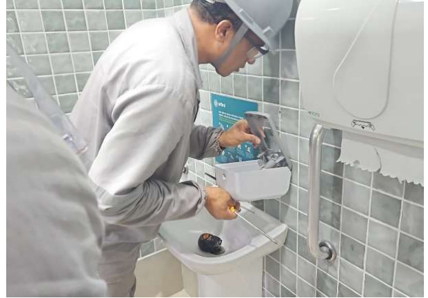
Figura 139 troca de dispensers quebrados
