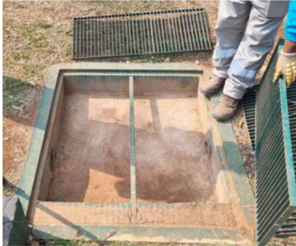
Figura 400 Limpeza dos sistemas de drenagem externo
