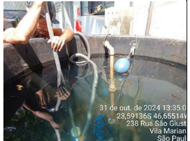
Figura 262 Higienização dos reservatórios de água potável - Orangebio - Parque Ibirapuera
