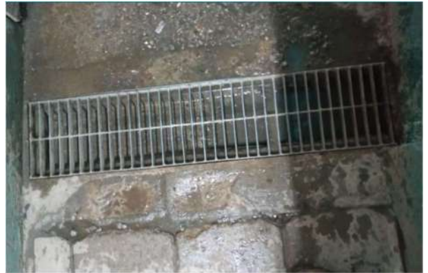
Figura 369 Limpeza na grelha do Refeitório
