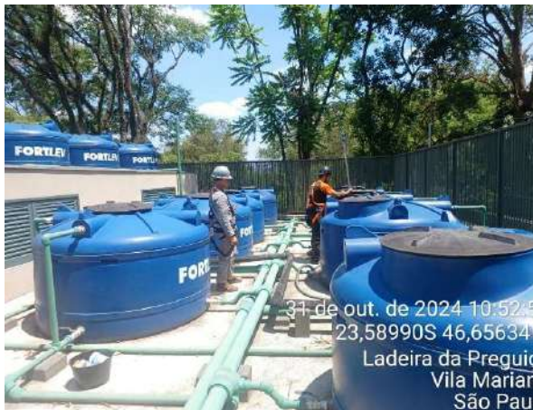
Figura 261 Higienização dos reservatórios de água potável - Orangebio - Parque Ibirapuera
