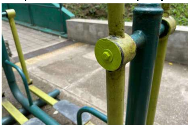
Figura 395 Substituição de rolimã do aparelho de academia - Parque Lajeado
