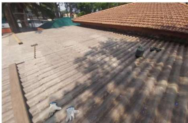
Figura 379 Limpeza no telhado do escritório Ambicap
