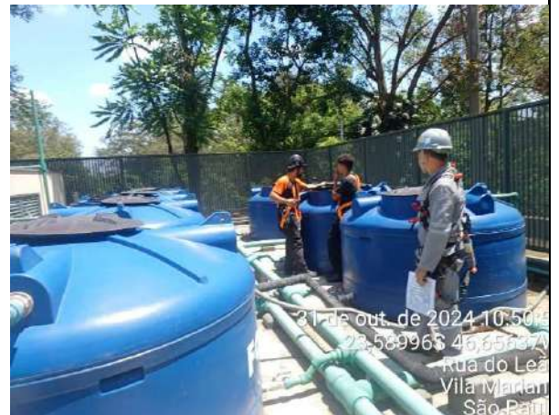
Figura 262 Higienização dos reservatórios de água potável - Orangebio - Parque Ibirapuera
