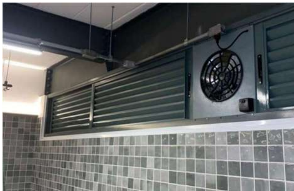
Figura 375 Instalação dos exaustores no vestiário do Hub Centauro
