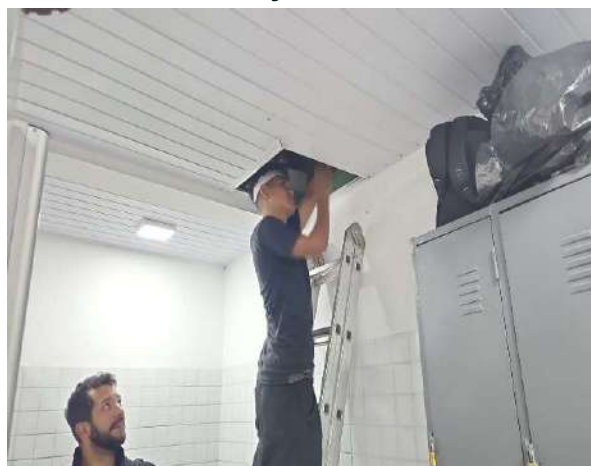
Figura 264 Higienização dos reservatórios de água potável - Orangebio - Parque Lajeado
