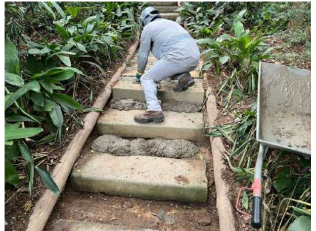
Figura 96 cobertura de concreto em degraus de escada (durante)
