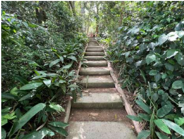
Figura 95 cobertura de concreto em degraus de escada (durante)
