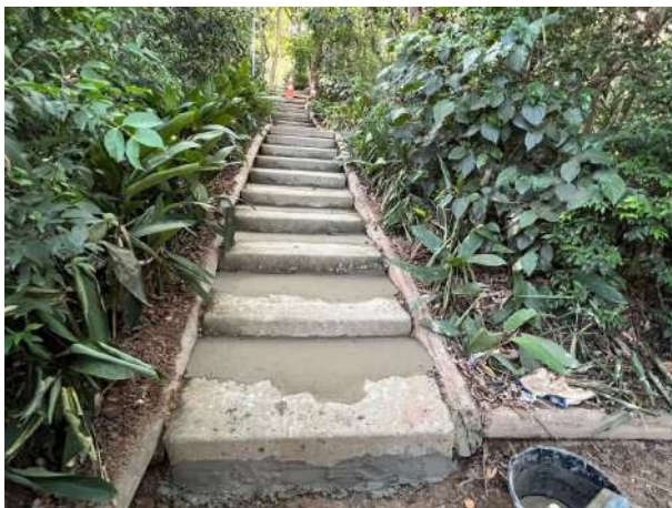
Figura 95 cobertura de concreto em degraus de escada (durante)
