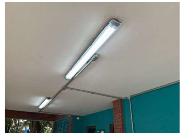
Figura 90 substituição de lâmpadas queimadas
