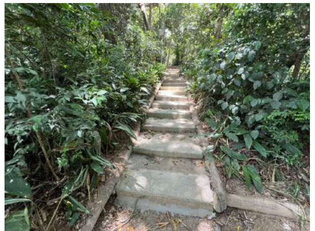
Figura 96 cobertura de concreto em degraus de escada (durante)
