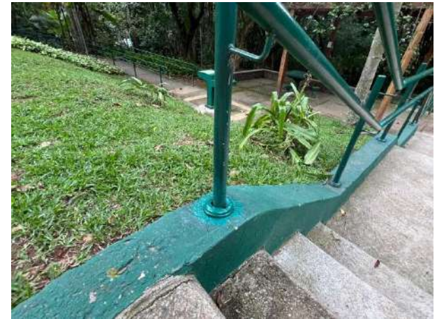
Figura 88 solda em haste de corrimão (depois)
