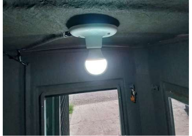
Figura 92 manutenção de fiação e substituição de lâmpada da guarita (depois)
