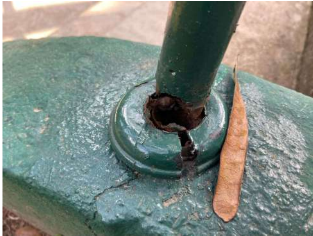
Figura 87 solda em haste de corrimão (durante)
