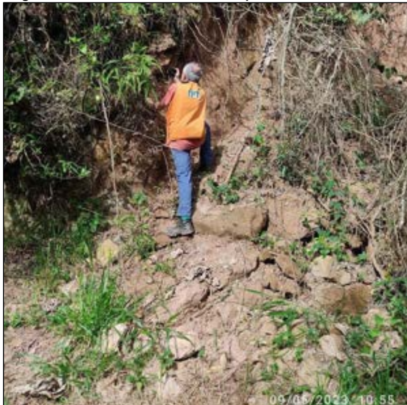
Figura II: 50 – Detalhe da massa rompida na base do talude.
