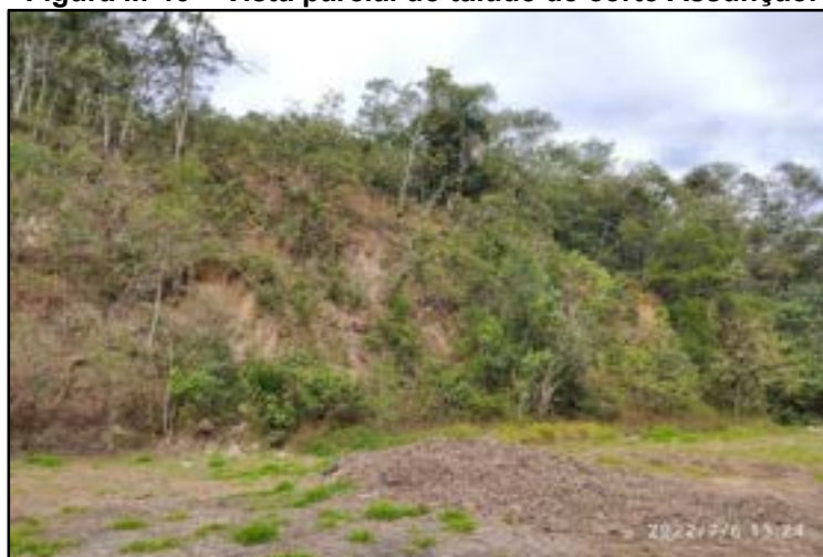
Figura II: 46 – Vista parcial do talude de corte Assunção.
