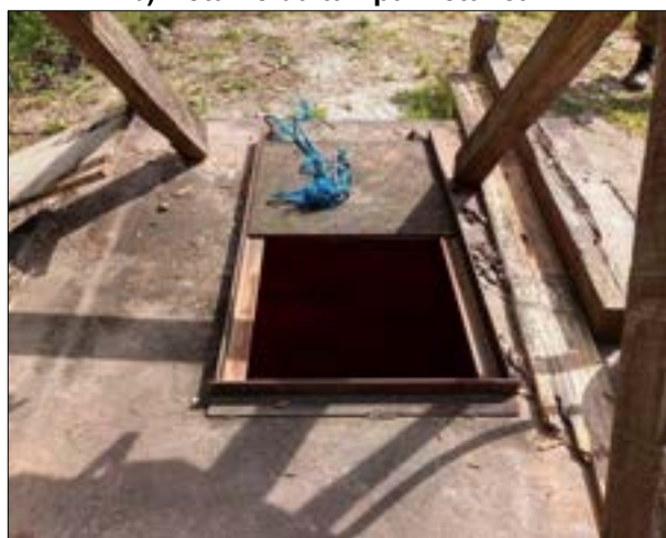
b) Detalhe da tampa metálica
