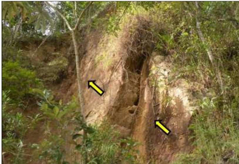
Figura II: 49 – Detalhe da foto anterior - ruptura observada no talude Assunção
