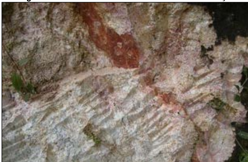
Figura II: 53 – Detalhe da foto anterior – talude Assunção.
