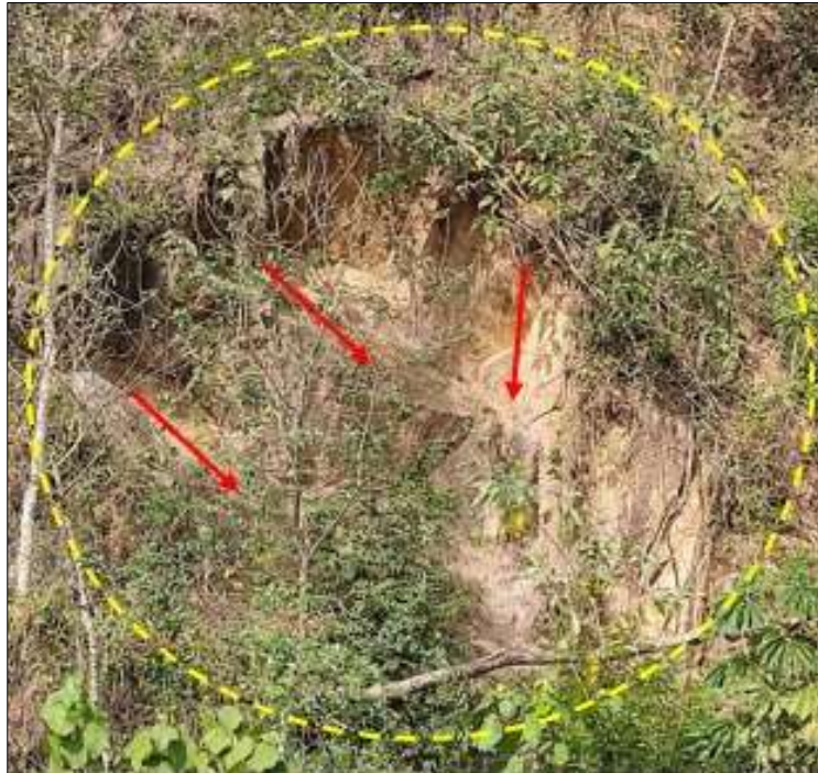
Figura II: 51 – Vista parcial do talude Assunção.
