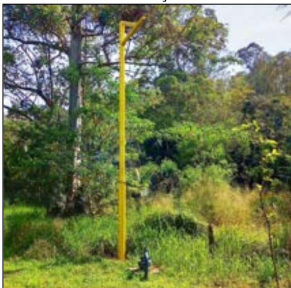
Figura II: 20 – Aspecto do Poço 1, que não apresenta cerca relativa ao Perímetro Imediato de Proteção Sanitária.
