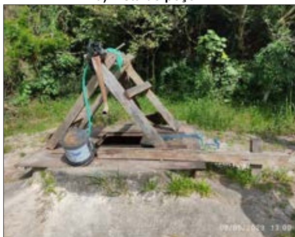
a) Vista do poço
