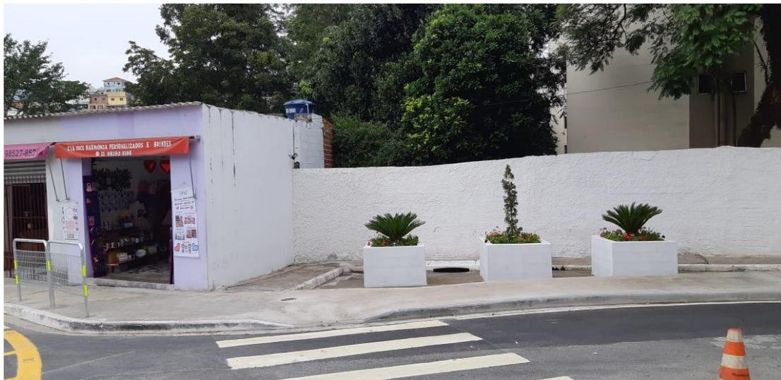
Adequação geométrica. Colocação de gradis metálico com aplicação de refletivos, em substituição às defensas metálicas. Construção de guia rebaixada e preservação das bocas de lobo atrás das floreiras
