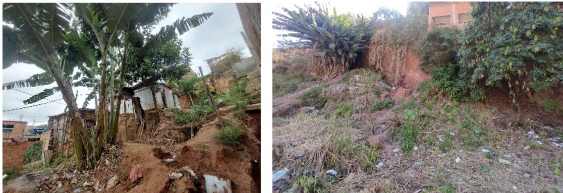
Figura 44: Imagens ilustrativas colhidas nas visitas de campo para mapeamento geológico-geotécnica da área de risco. Esquerda = área Nova União com trincas no solo e feições de deslizamento e Direita = área Vila Cais com delaminação do solo (Fonte: PMRR)
