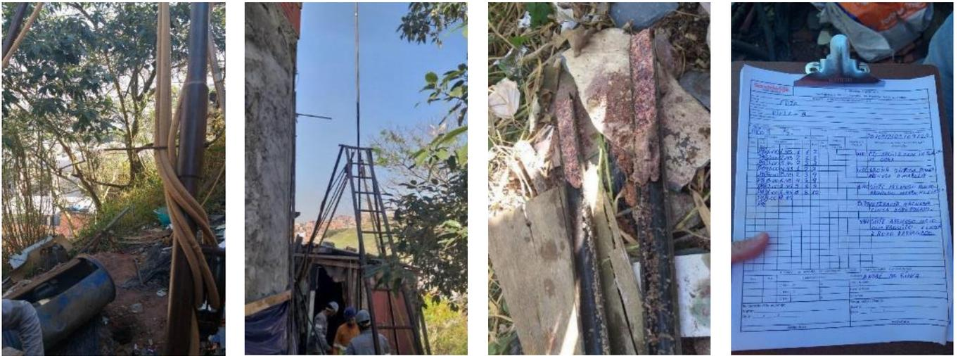
Figura 46: Sondagem SPT (Fonte: PMRR)
