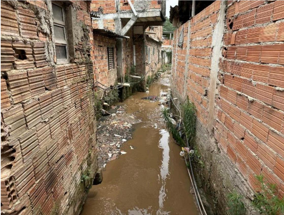
Figura 51: Foto visita IQ-07 – Maré Vermelha I – cana; com secção estreitada em função da ocupação. Notar presença de muito lixo (Fonte: PMRR)
