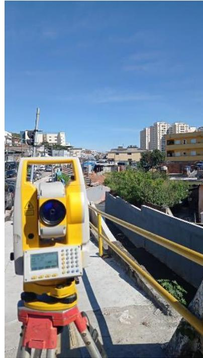
Figura 41: Levantamento Topográfico complementar (PMRR).
