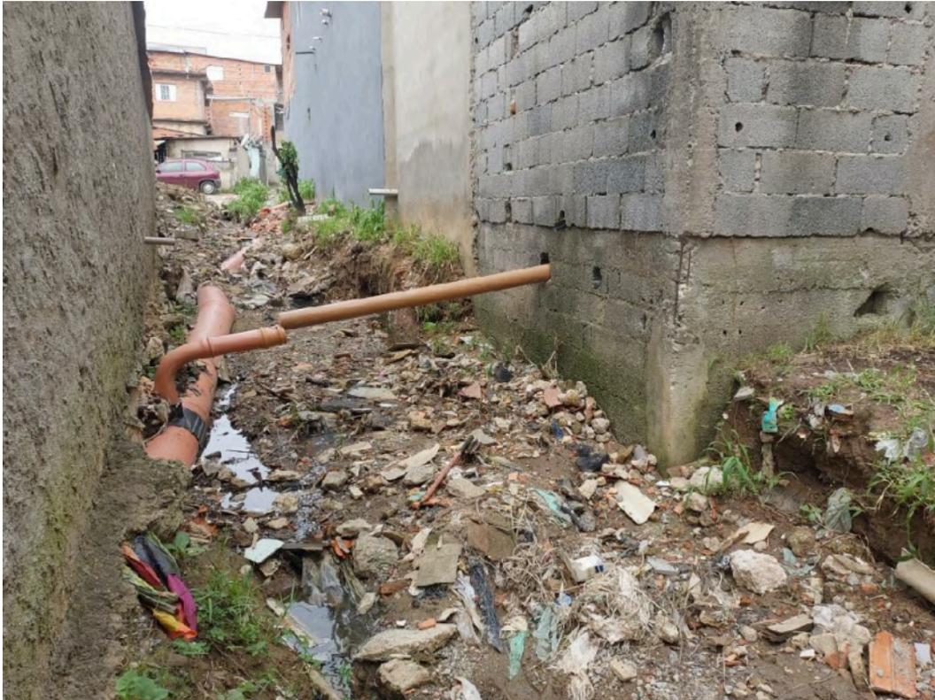
Figura 14: Tubulação de esgoto inadequadamente disposta na área de risco Vila Bella II - São Mateus (Fonte: PMRR)
