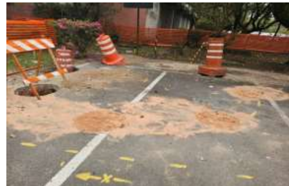
2 - Retirada da camada de asfalto.
