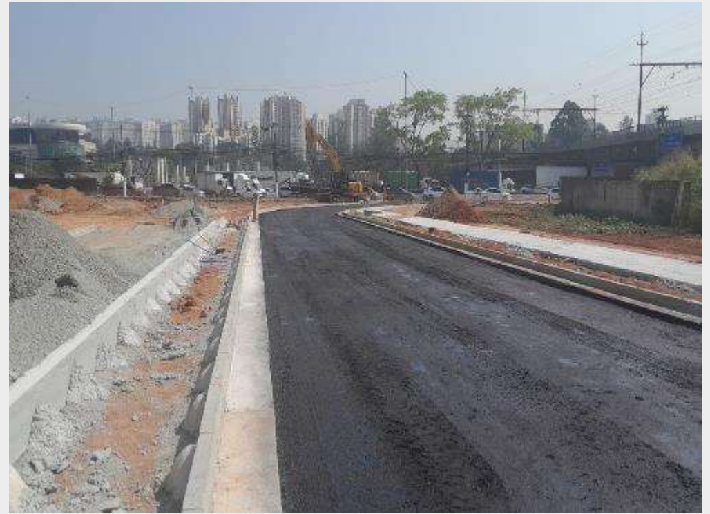
Serviço de pavimentação – Alça Sul, Lado Lapa
