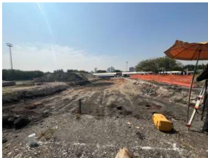
3 - Término das escavações.
