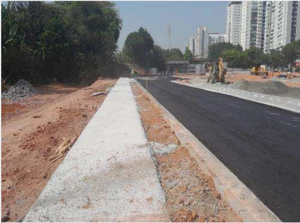
Serviço de pavimentação – Alça Sul, Lado Lapa
