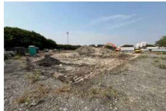
2 - Início das escavações.
