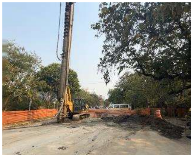
3 - Início do estaqueamento.
