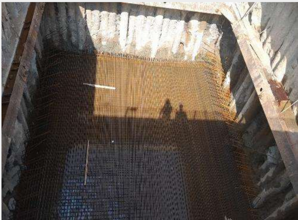
Montagem de Armação do bloco de fundação Apoio 2, Ponte (Lado Pirituba)
