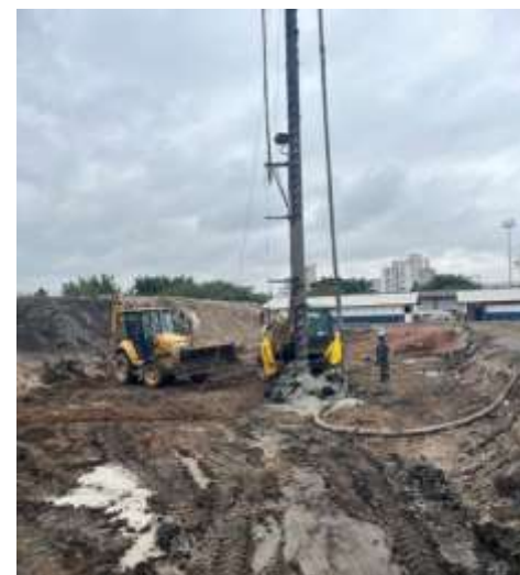
4 - Início do estaqueamento.
