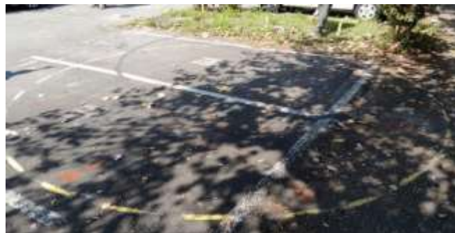
1 - Marcação dos furos.
