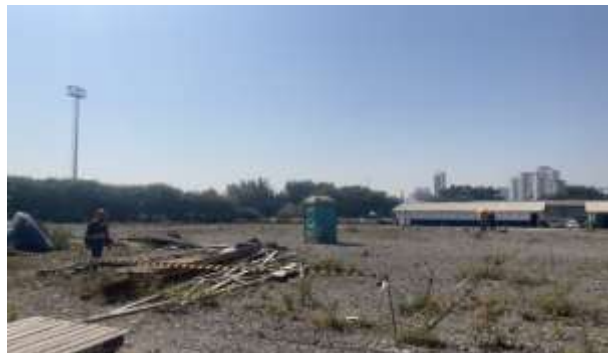
1 - Demarcação e locação topográfica do bloco 6.
