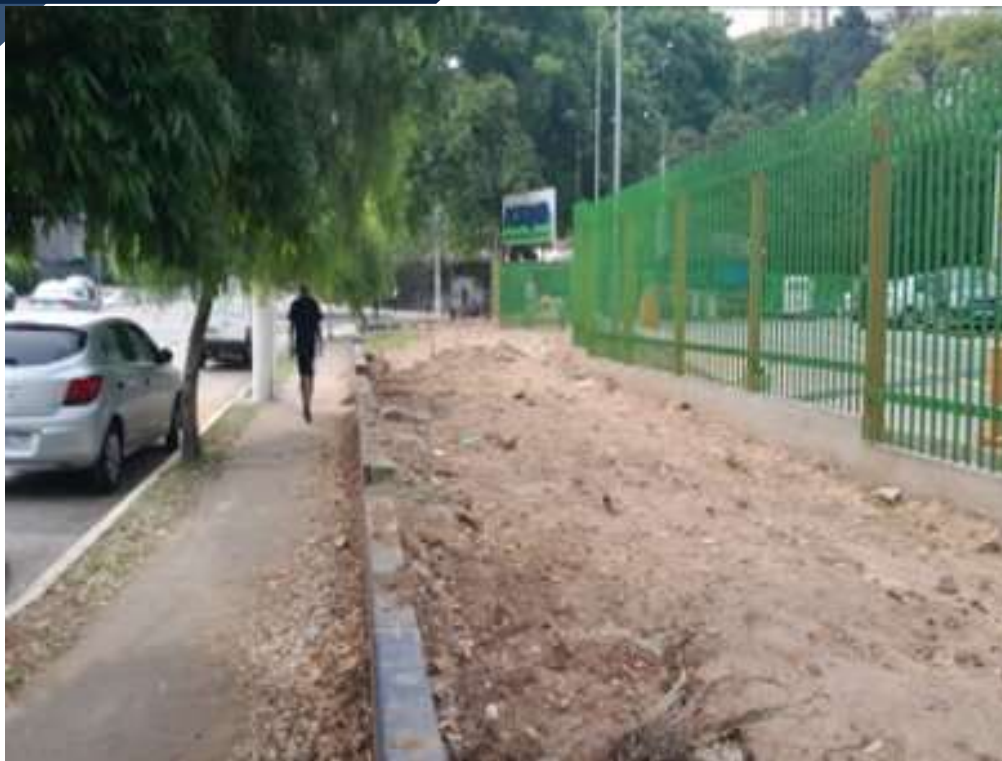
Obra de readequação expropriado Supermercado Pastorinho – Lado Pirituba
