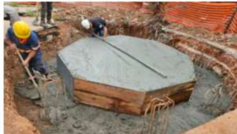
2 - Execução do concreto magro do bloco e a base da laje.
