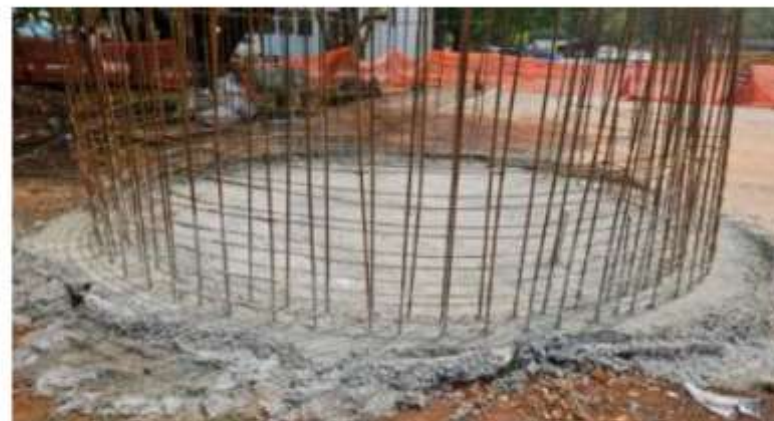
4 - Concretagem da base da caixa d'água.
