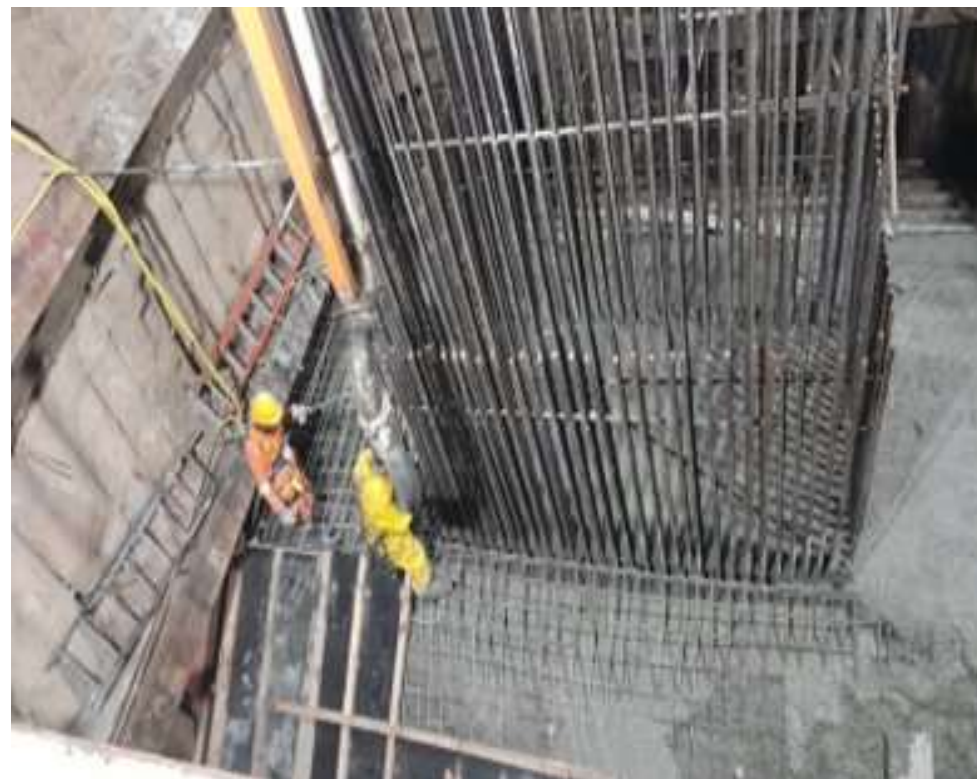
Concretagem do bloco de fundação Apoio 2 – Direito, Ponte (Lado Pirituba)
