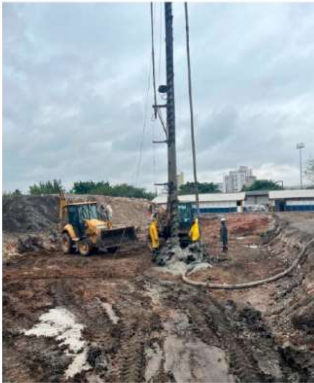
1 - Início do estaqueamento.
