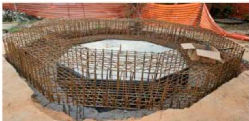
3 - Armação da base da caixa d'água.
