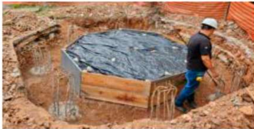
1 - Montagem da forma.
