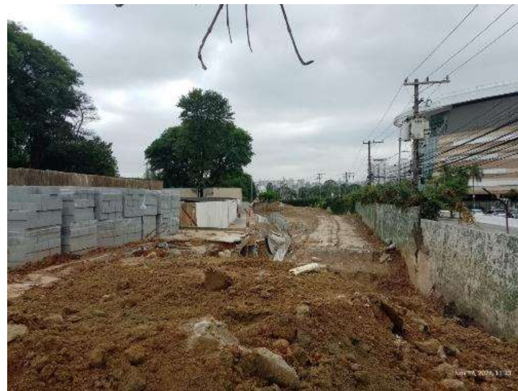
Obra de readequação expropriado Condomínio Village – Lado Pirituba
