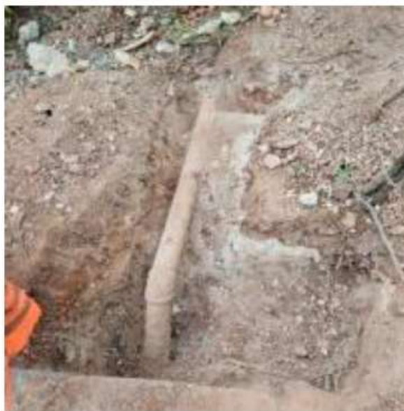
5 - Escavação para encontrar tubulação de ligação do antigo reservatório.
